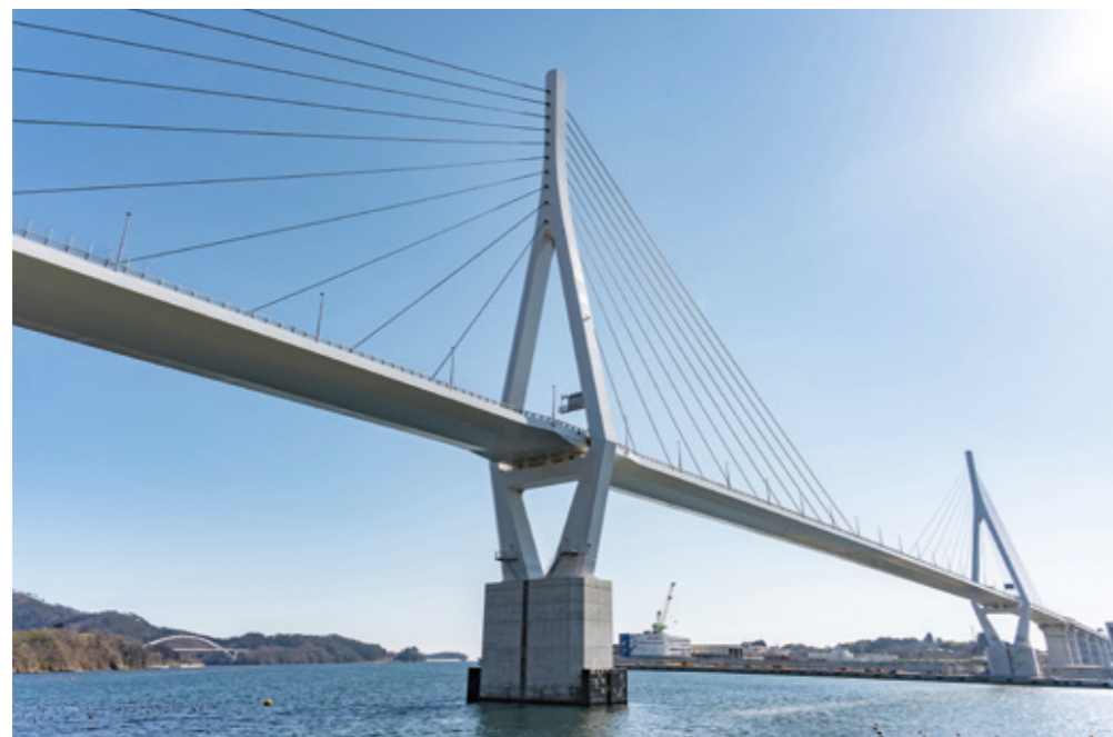
Kesennuma Bay Crossing Bridge (Kanae Ohashi)
