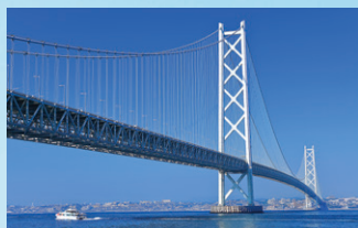
明石海峡大橋
