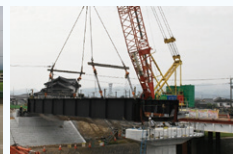
復旧工事の様子
