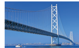
明石海峡大橋
