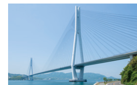
多々羅大橋
