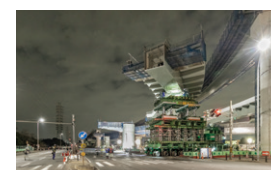
飛島木場高架橋
