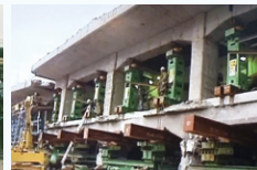
ジャッキアップの様子
