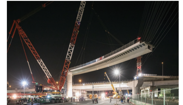
飛島ジャンクションCランプ橋 (NEXCO中日本)
