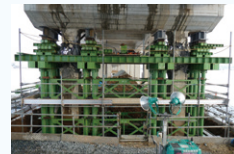
RC高架橋支柱緊急対策
