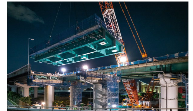
吹田JCT～中国池田IC間橋梁更新工事 (NEXCO西日本)
