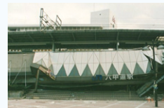
六甲道駅被災状況
